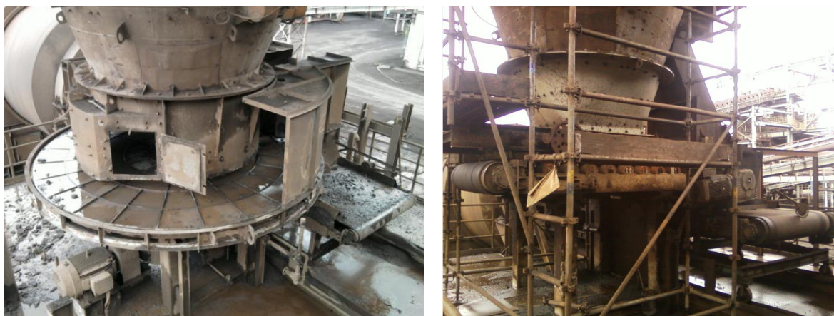
Figura 10. (a) Table Feeder - Antes; (b) Alimentador de Correia – Durante a montagem. Fonte: Autor.
